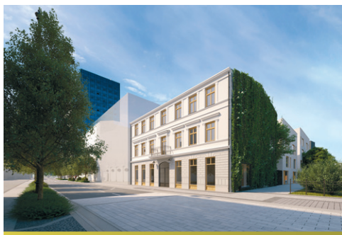
Rysunek 1. Przebudowa zespołu budynków przy ul. Sienkiewicza 79 w Łodzi w ramach Projektu 6 Rewitalizacji Obszarowej Centrum Łodzi – tzw. zielona ściana – pnącza na konstrukcji stalowej instalowanej do elewacji budynku. Źródło: Miasto Łódź – Zarząd Inwestycji Miejskich (2016, s. 42)
