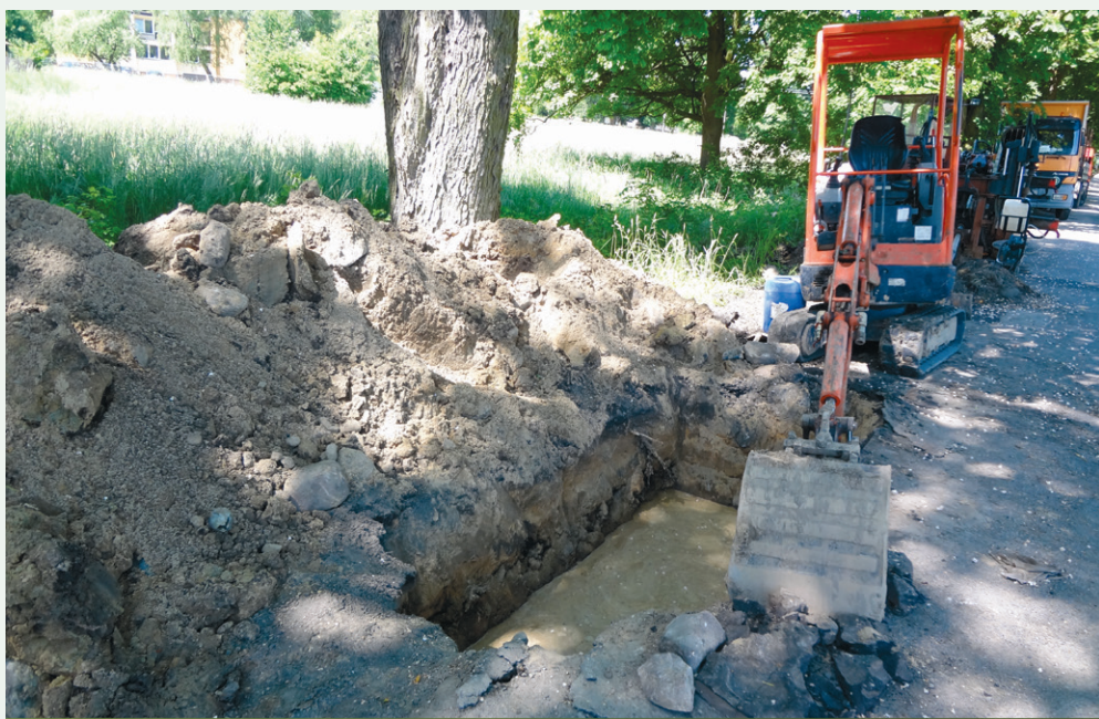
Rysunek 6. Wykonywanie prac budowlanych w systemach korzeniowych drzew metodą wykopu otwartego z użyciem koparki
