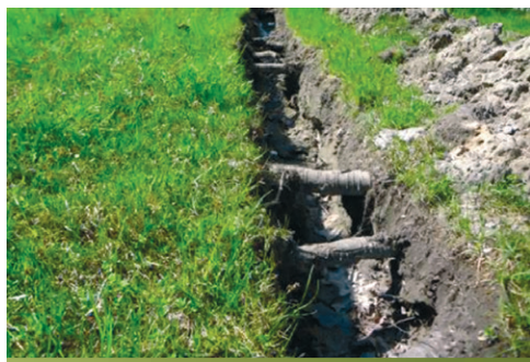
Rysunek 4. Ręczne kopanie rowów pod instalacje może być przeprowadzone w sposób przyjazny drzewom – na zdjęciu pozostawione korzenie drzew
