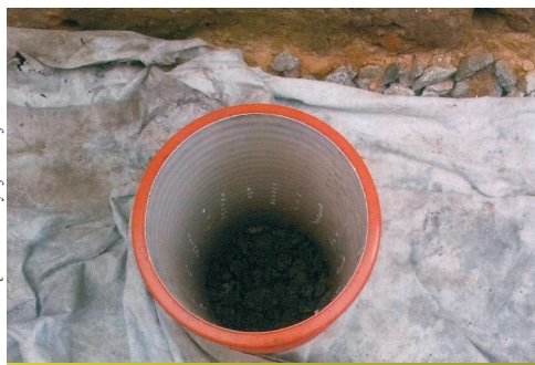
Rysunek 3. Podłoża strukturalne i studzienki nawadniające drzewa i roślinność przyuliczną w ramach remontu i przebudowy ulicy Gdańskiej w Łodzi
